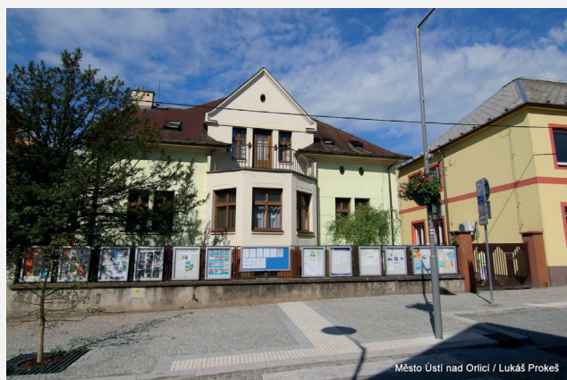
Stávající objekt stacionáře na adrese T.G.Masaryka 123
