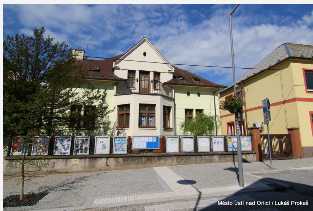
Stávající objekt stacionáře na adrese T.G.Masaryka 123
