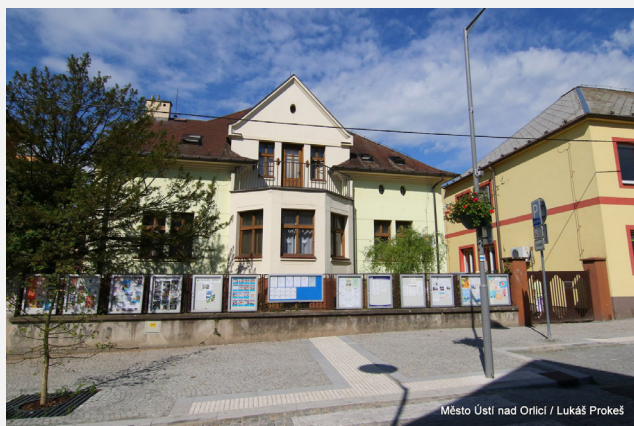
Stávající objekt stacionáře na adrese T.G.Masaryka 123
