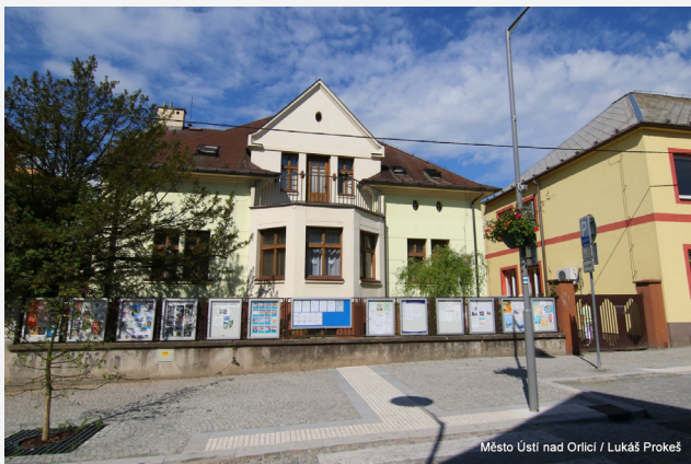
Stávající objekt stacionáře na adrese T.G.Masaryka 123
